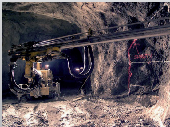
Extraction en galeries souterraines
